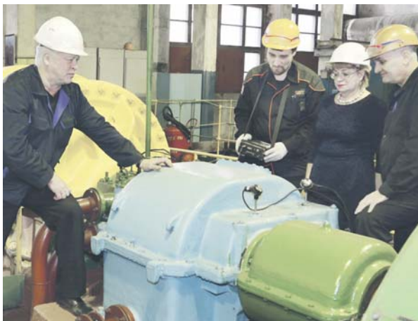
Замер уровня вибрации электрокомпрессора в цехе 850
